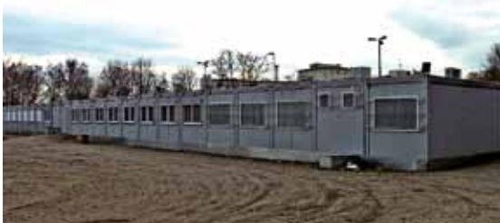
Die „Zwischenlösung“: Container.
